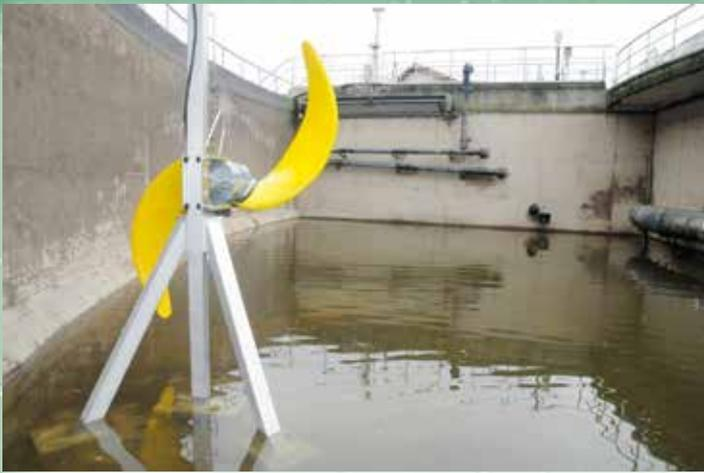
Das Bild zeigt den Blick ins Klärbecken mit energieeffizientem Rührwerk.
